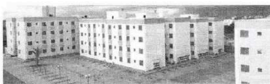
Em Uberlândia, por exemplo, serão construídas 448 unidades pela MKV Engenharia. Foto: Jairo
